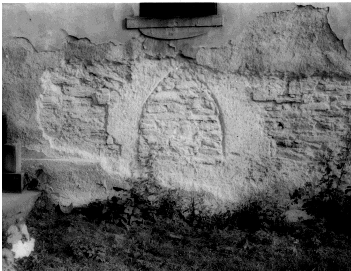
Zazděný gotický portál na severní straně kostela, objevený roku 1983.
